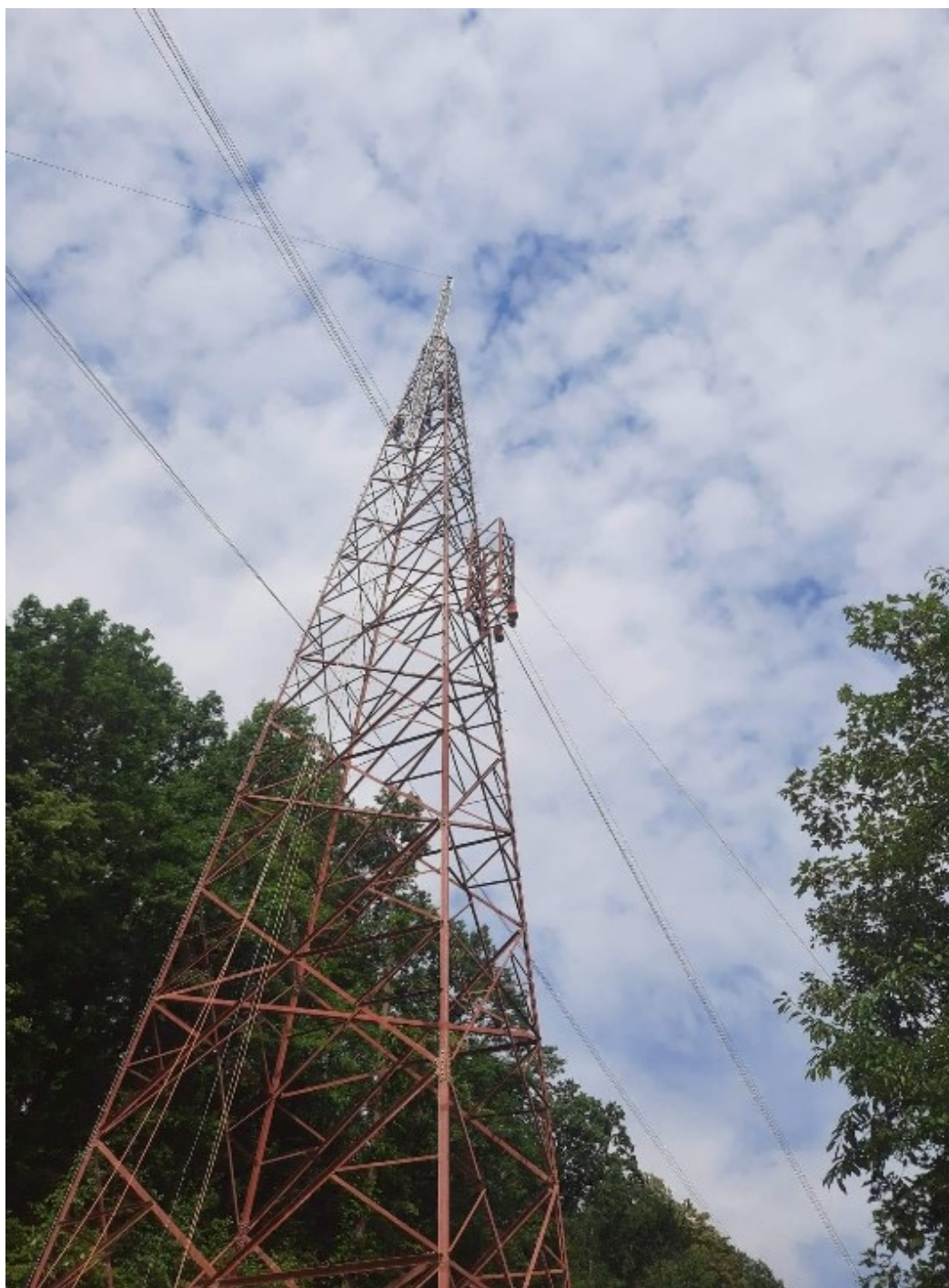
Figur 4. Derrick i brug ved demontering af mast.
